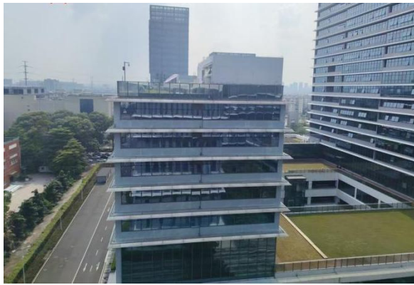
项目西面：园区 A2 栋
